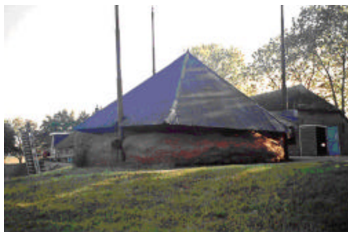
Fig. 7 Meule de foin recouverte d'un toit amovible.
